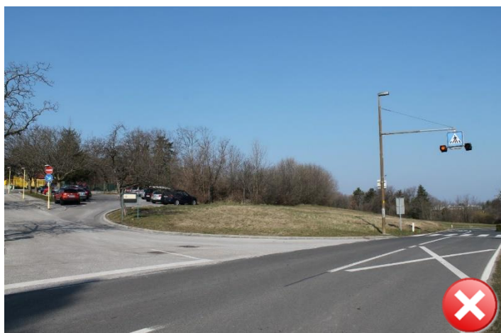
Slika 9: Nevaren odsek brez pločnika iz smeri Skopo.
